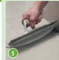
Hordj fel a második réteg Aquastop Nanoflex®-et
