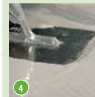
Az Aquastop AR1-et az Aquastop Nanoflex® első rétegébe dolgozza be
